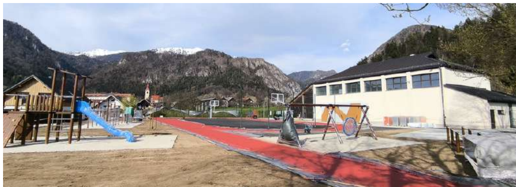
Zaključna dela prenove športnega igrišča pri osnovni šoli
